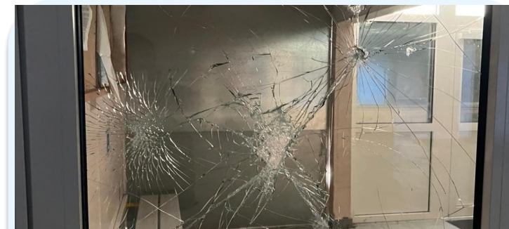
Intérieur de la piscine
