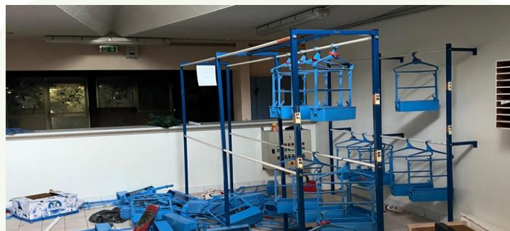
Intérieur de la piscine
